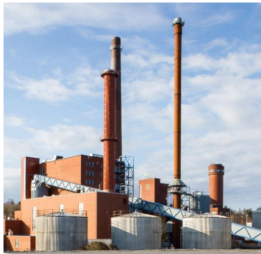
Uusi biovoimalaitos Nokialla
